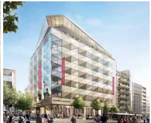
Le département Store des Galeries Lafayette
