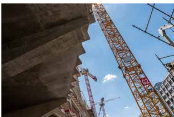
Ciel ouvert sur espaces couverts
