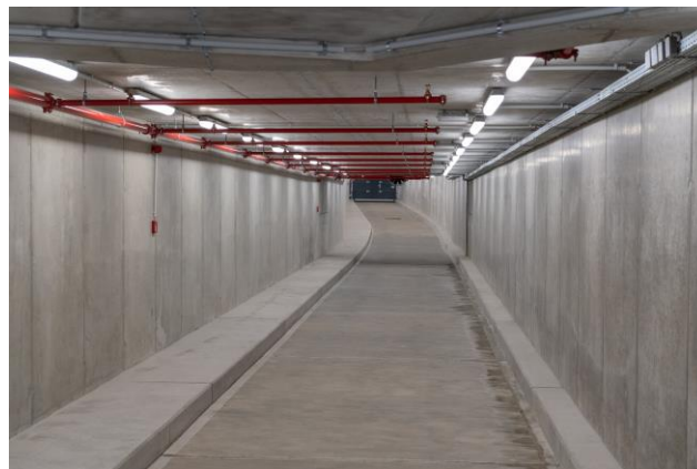
La rampe d'accès terminée
