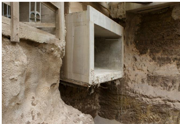
Construction de la rampe d'accès sous le Boulevard Royal
