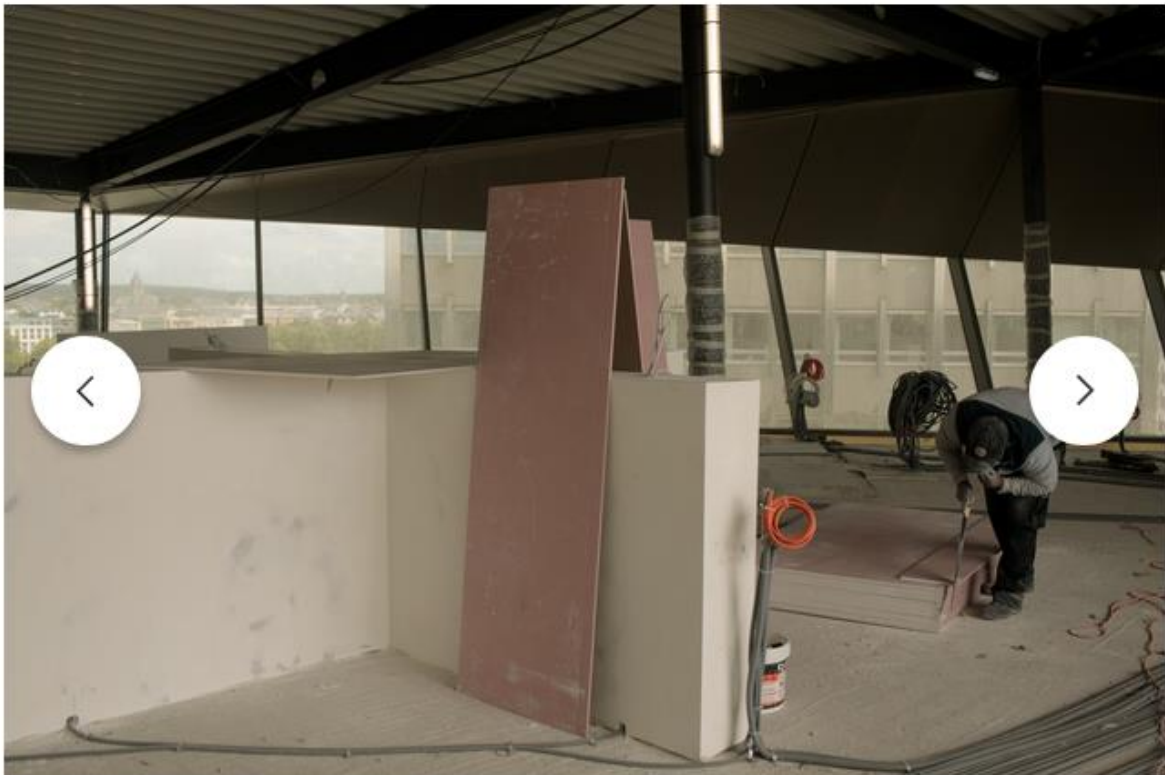
Pour l'heure, les ouvriers s'affairent dans le futur espace du restaurant péruvien Manko. (Photo: Matic Zorman / Maison Moderne)
